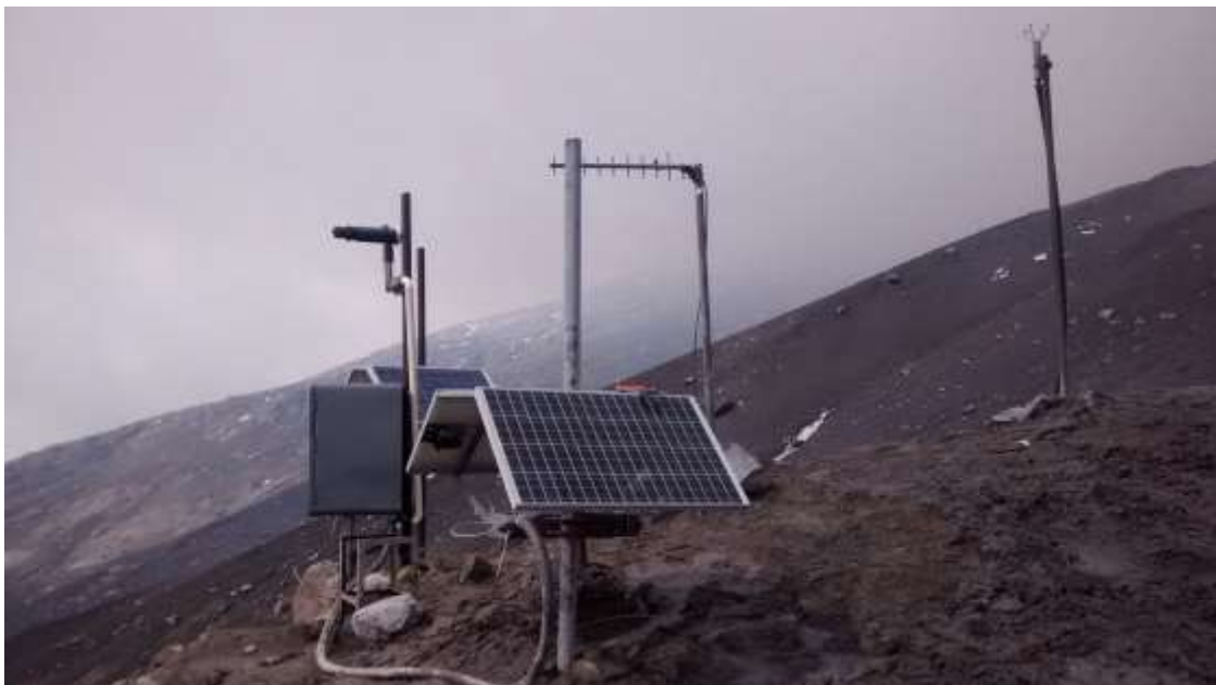
Figura 2. Adecuaciones del sistema de protección de equipos (Gabinete en fibra) y estructuras de soporte de paneles solares en la estación multiparamétrica GUALI.
