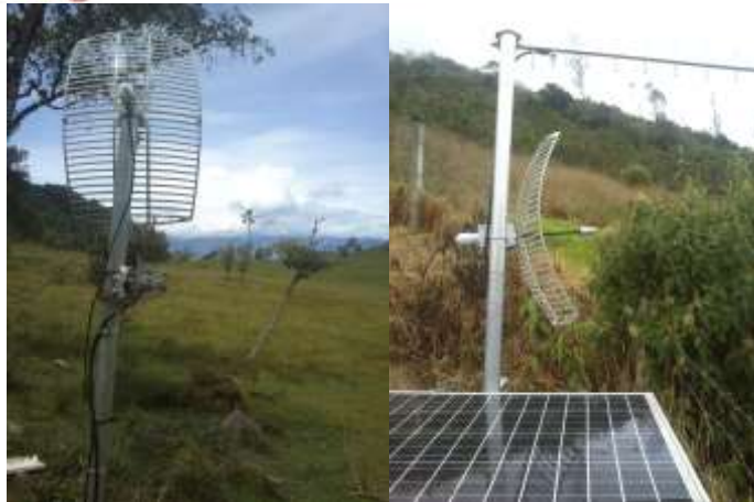
Figura 50. Imágenes del sistema de radio de 5GHz en las estaciones LAGUNA y LA SECRETA.
