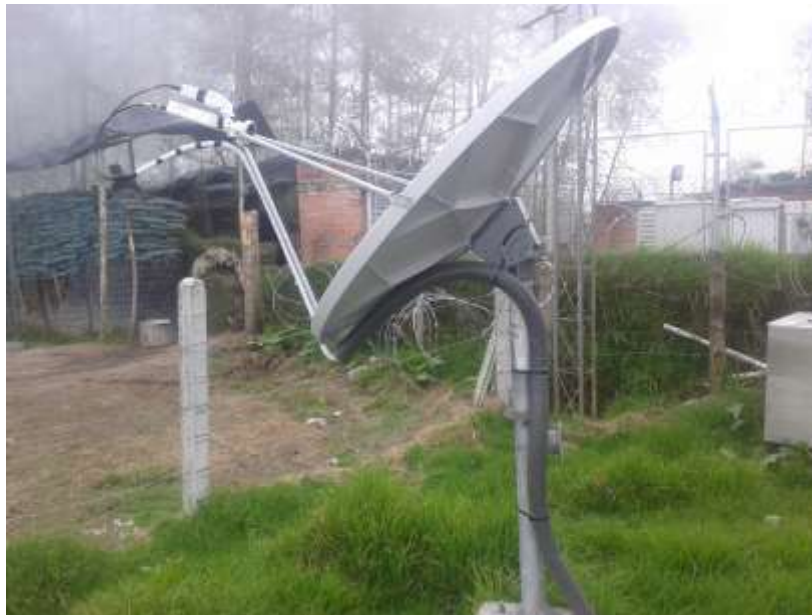
Figura 49. Antena satelital en la repetidora CIELO ROTO.
