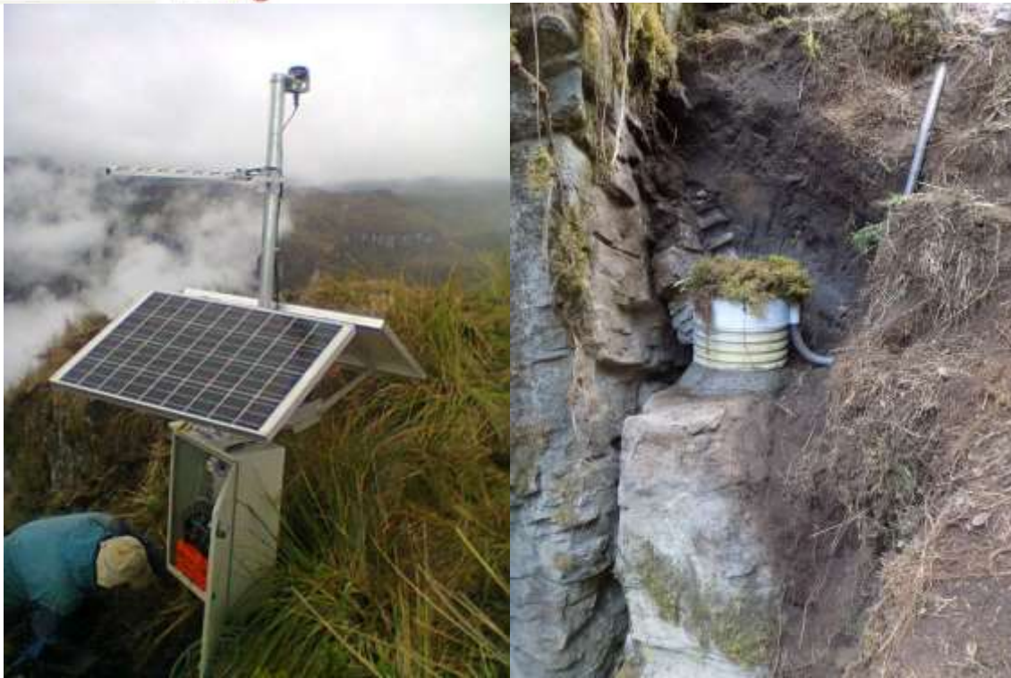
Figura 87. Estación de banda ancha EL AGUILA.
