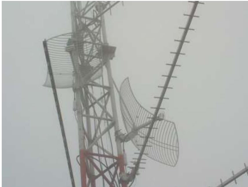
Figura 77. Implementación de Equipos de transmisión 2,4 GHz en la repetidora CERRO BRAVO.
